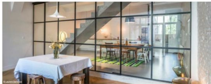
Verrière d'atelier réalisée par l'atelier de ferronnerie contemporaine Atmos.FER à Quint-Fonsegrives.
